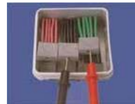
3- Bağlantının doğruluğunu test etmek için yuvayı, voltaj test aleti ile kontrol ediniz.
